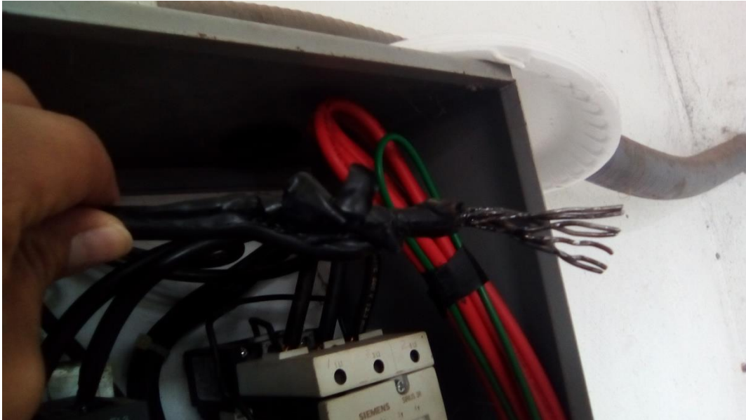
Imagen 6. Cambio de conductores del arrancador de la bomba ubicada en la U.H. Olivos
