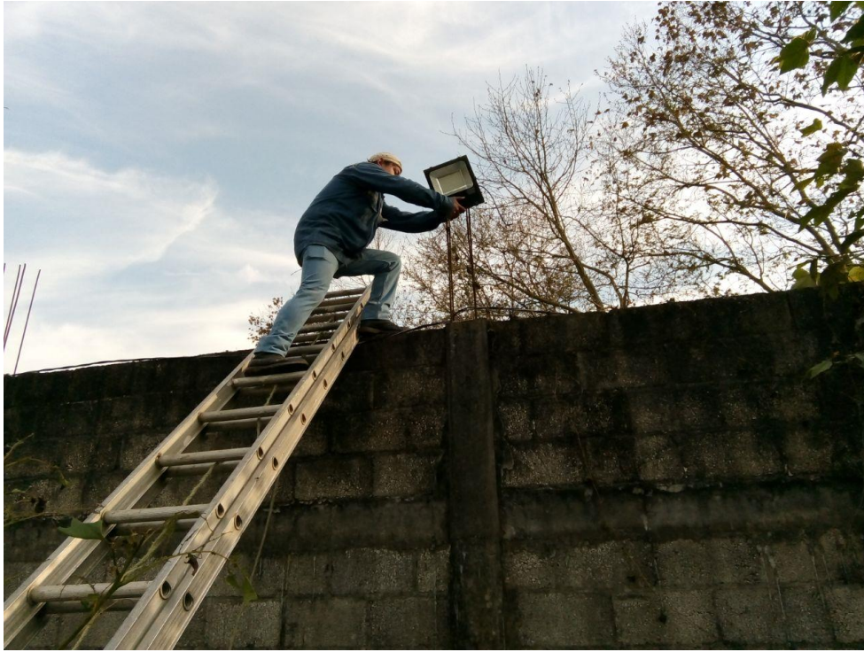
Imagen 7. Instalación de luminarias para la feria municipal
