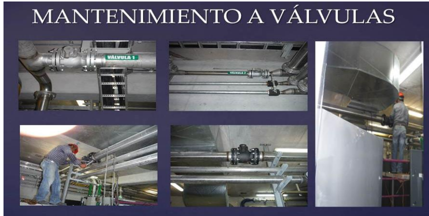
Ilustración 9 mantenimiento a válvulas
