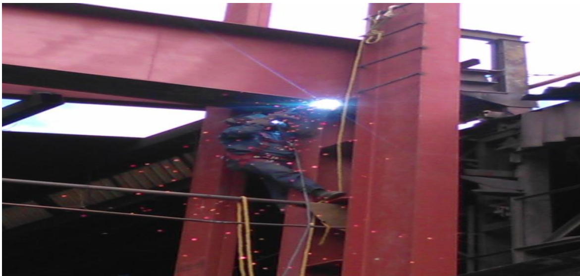
Figura 2.7 Soldadura en viga.
