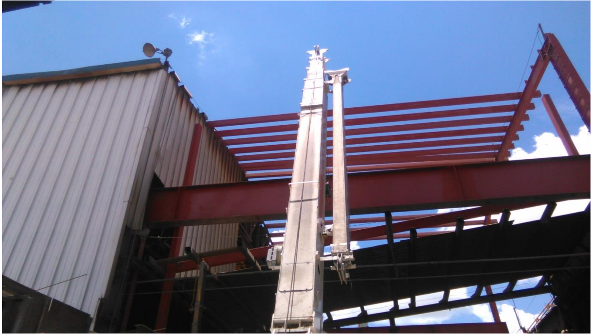
Figura 3 Montaje de trabe carril derecha.
