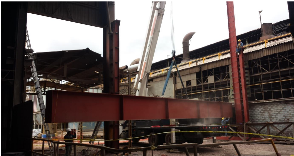
Figura 3.1: Montando trabe carril izquierda.
