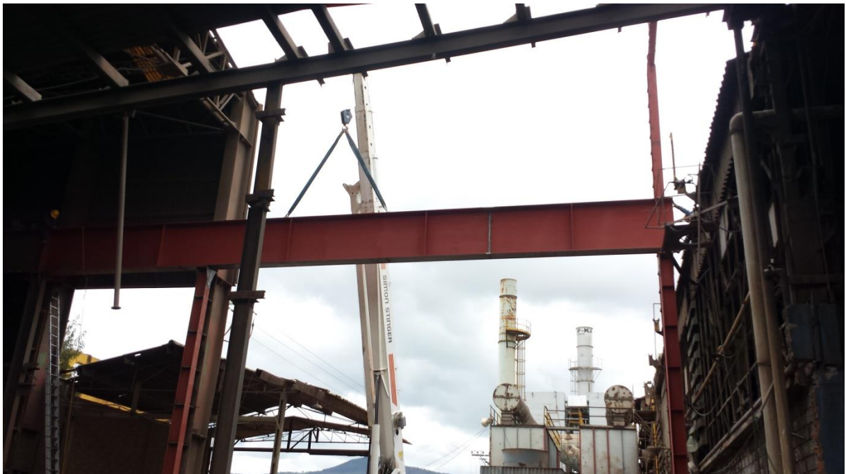
Figura 3.3 Trabe carril en montaje.
