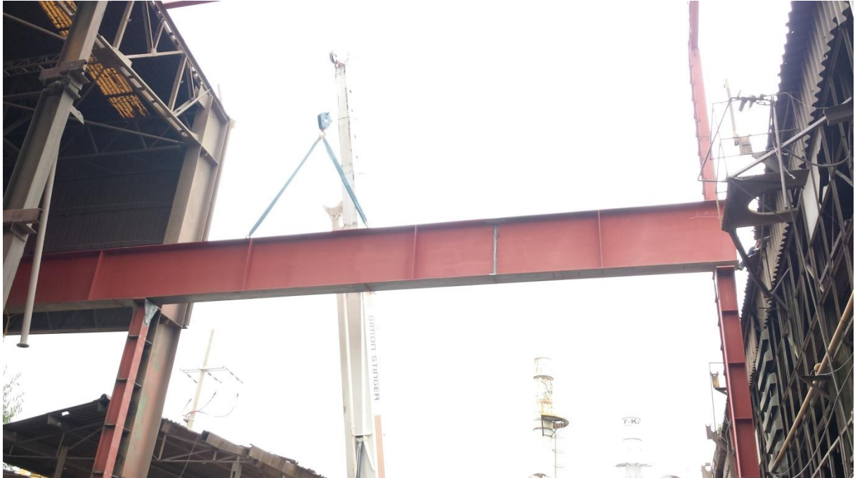
Figura 3.2: Trabe carril siendo montada.
