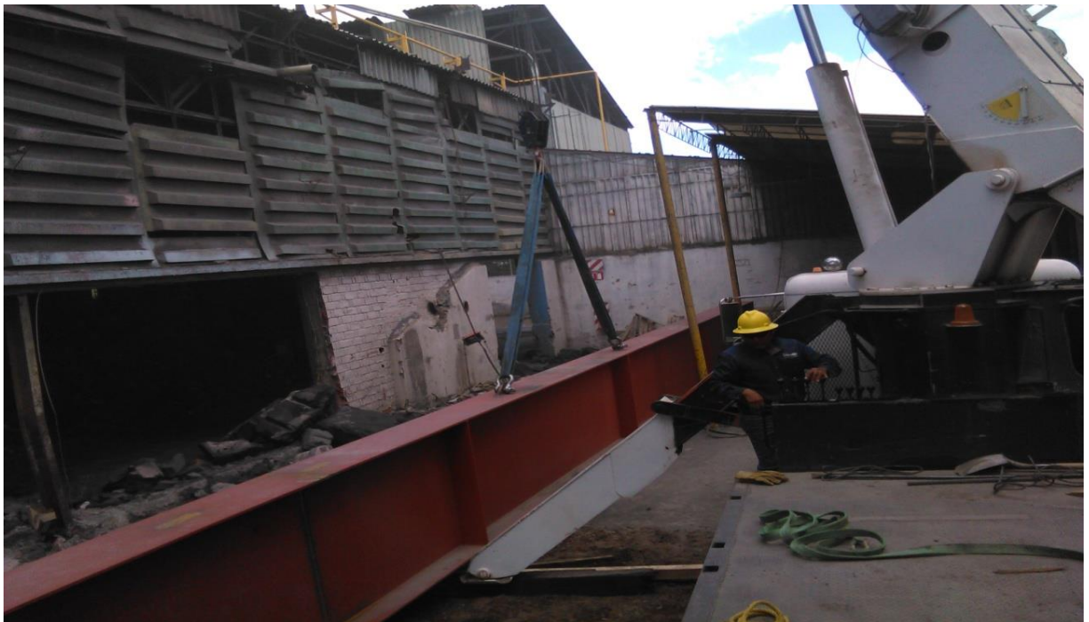
Figura 2.9 Estrobando pieza para montar.
