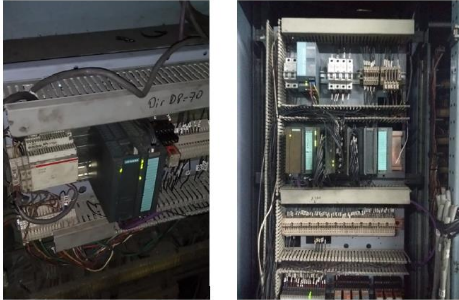
Figura 54. Lectura de señales en los controles remotos
