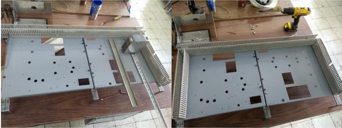
Figura 24. Colocación de canaletas
