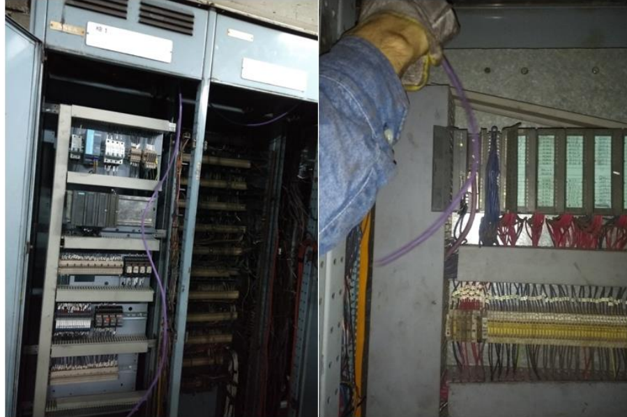
Figura 35. Conexión de PROFIBUS
