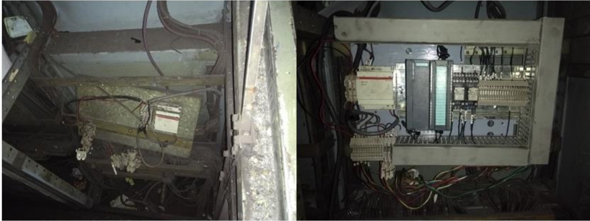
Figura 46. Retiro y montaje de nuevo control remoto
