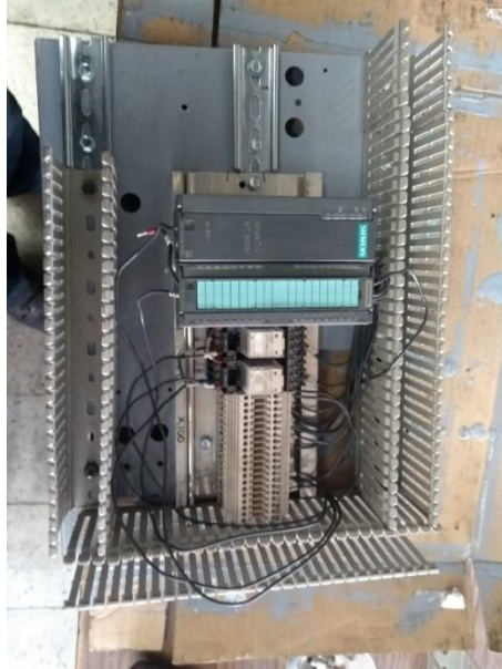
Figura 44. Colocación de riel din
