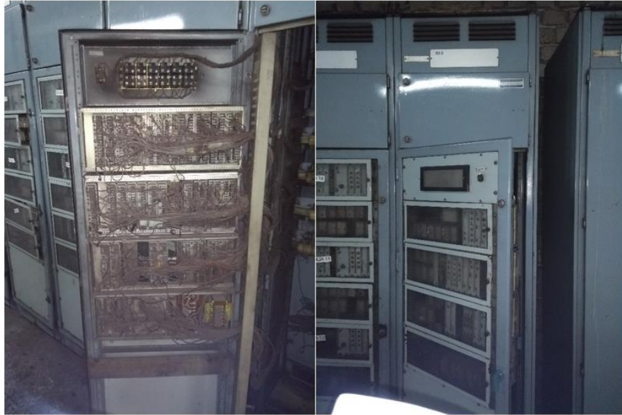
Figura 55. Control analógico a reemplazar
