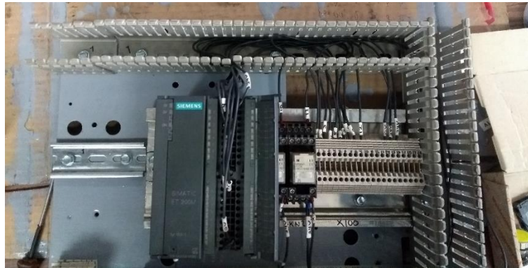
Figura 45. Conexión y etiquetado de cables
