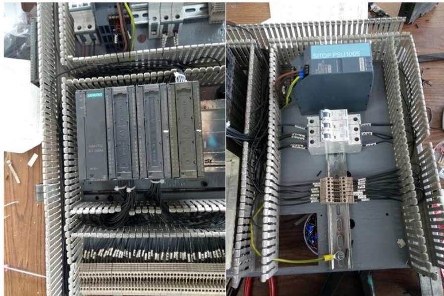
Figura 29. Colocación de 24V y 0v
