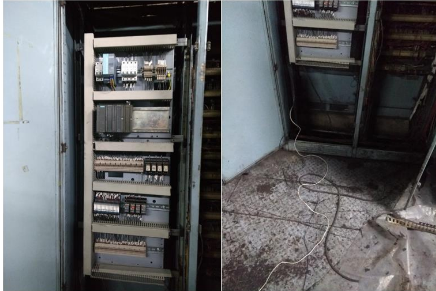
Figura 34. Montaje de tablero en gabinete
