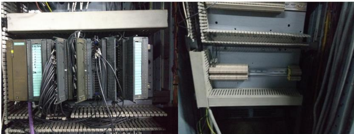
Figura 38. Montaje de nuevos módulos
