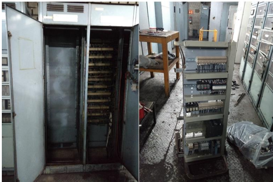
Figura 33. Limpieza de gabinete y transporte de tablero
