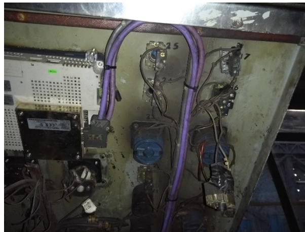
Figura 47. Conexión PROFIBUS
