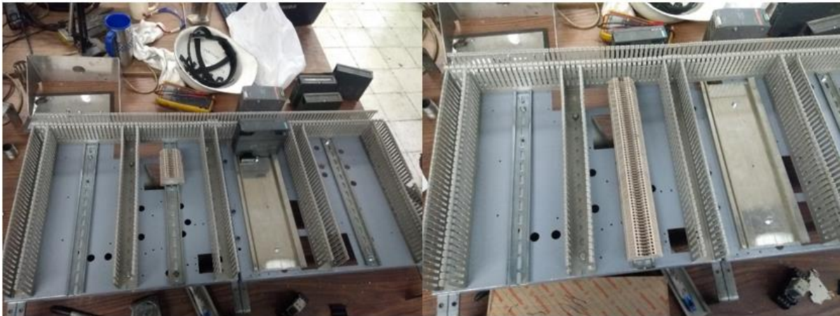
Figura 25. Colocación de riel din
