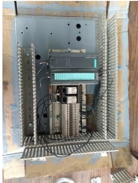
Figura 43. Montaje de remoto, relés y bornas
